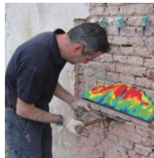
土木工程压力分布测试
